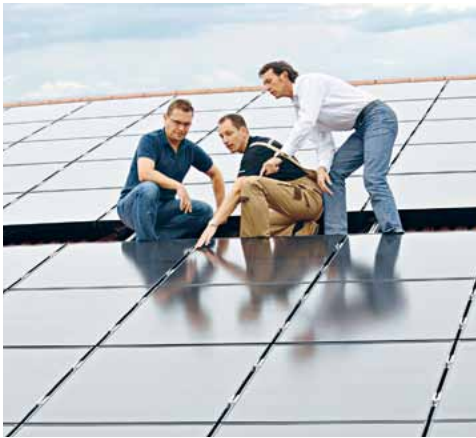
Mit Komplettleistungen wie bei der Realisation einer Photovoltaikanlage auf dem Dach des Eigenheims entlastet die BayWa private Bauherren.
