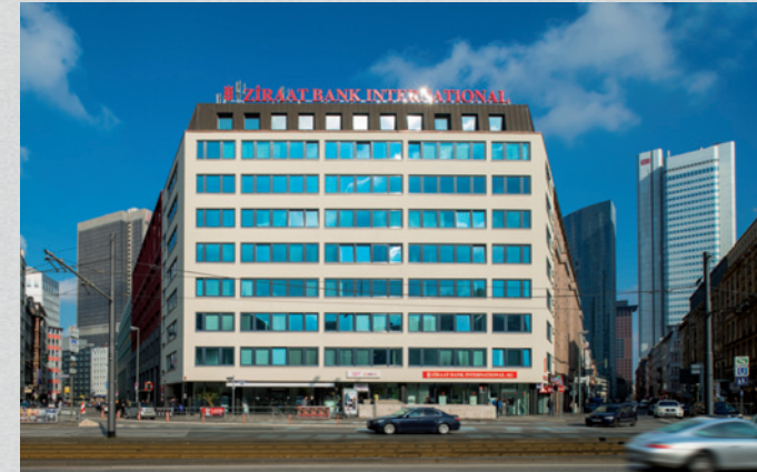
Bürostandort direkt am Hauptbahnhof Frankfurt: Erworben für das Commercial Portfolio
