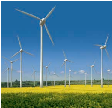
Anlagen zur Energieerzeugung ermöglichen
