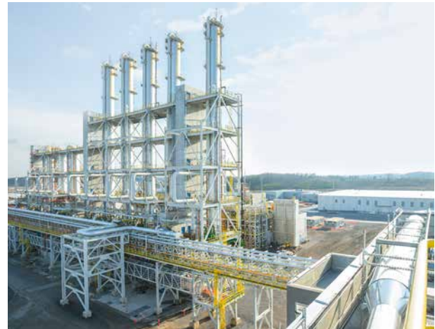
Das Geheimnis des hochreinen Polysiliciums liegt in der Prozessführung bei der Destillation.
