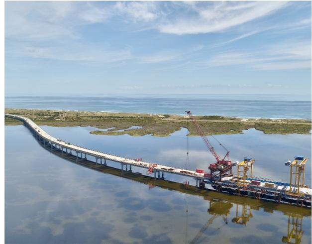
Beitrag zum Artenschutz: Auf dem Dach der Turner-Niederlassung Portland wurde ein Bienenstock angelegt (links). Um die Rodanthe-Brücke vor der Küste von North Carolina zu bauen, setzt Flatiron selbst entwickelte Techniken wie das Advancing Rail System ein. Durch diese Schienenkonstruktion werden Flora und Fauna besser geschützt (rechts).
