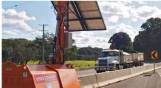
ges Warnsystem ein. Mit dem „Visionstream Telepath™ CB Radio Highway Alert System“ werden zu schnell fahrende Fahrzeuge per Radar identifiziert und über UHF-Radiofunk zum Beispiel auf ihre überhöhte Geschwindigkeit und auf die Baustelle hingewiesen.
