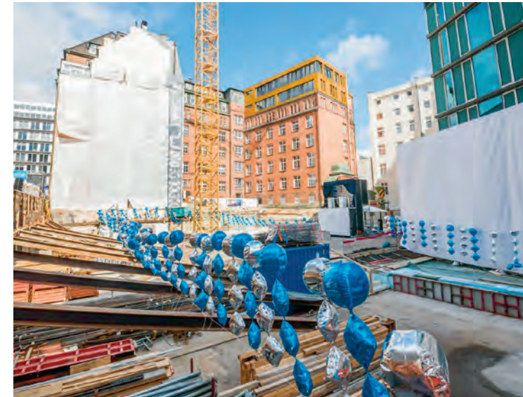
„Opera Offices NEO“ Grundsteinlegung Mai 2015, rund 60% vor Fertigstellung vermietet
