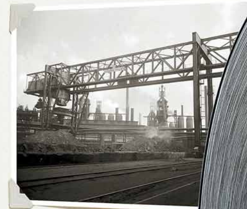
Wohlerverladung mit neuer Verladebrücke
