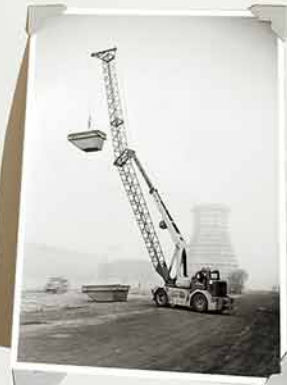
Mobile Kran Hüttenanlage
