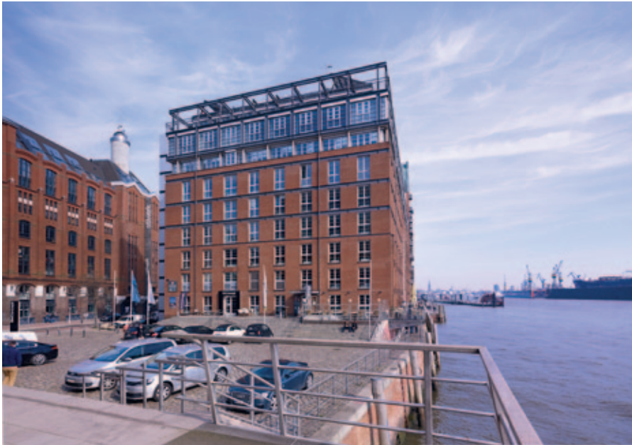
Der Elbspeicher gehört zu dem im Juli 2014 gestarteten Fonds „DIC Office Balance II“, der in den Top-7-Städten und wirtschaftsstarken Metropolregionen in Deutschland investiert ist. Binnen kürzester Zeit nach Ankauf haben wir für das teilweise leerstehende Gebäude ein erfolgreiches Umnutzungskonzept erarbeitet und Vollvermietung erreicht.
