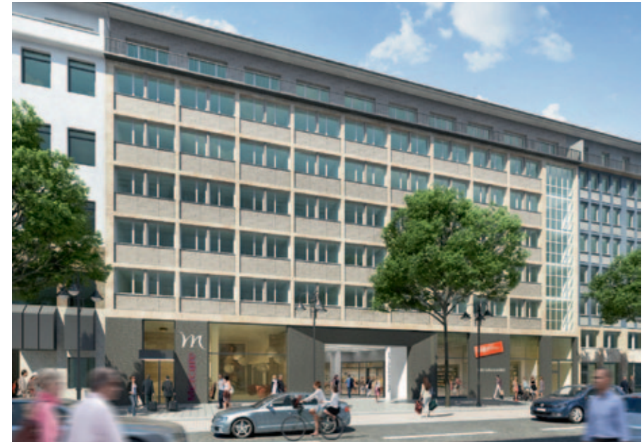
Das bestehende Mercure Hotel Kaiserhof wird seine Fläche um die zuletzt als Büros genutzten Etagen im Gebäude Kaiserstraße erweitern, und mit ipartment, einem Anbieter von „Wohnen auf Zeit“, konnte ein weiterer langfristiger Mieter gewonnen werden, der nach Fertigstellung auf 1.700 m 2 Fläche 71 möblierte Business-Apartments anbieten wird. Neben insgesamt acht kleineren Ladenflächen wird im Erdgeschoss der Vollsortimenter tegut auf rund 1.600 m 2 Einzelhandelsfläche präsent sein.
