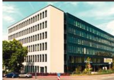
Büroobjekt Steubenhouse, Frankfurt
