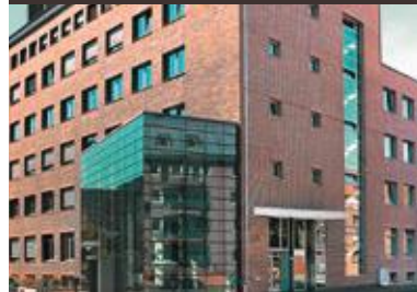
Büroobjekt BRIXX, Frankfurt
